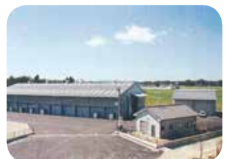
堆肥化施設全景
