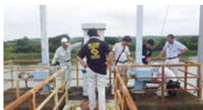
大淵排水機場
