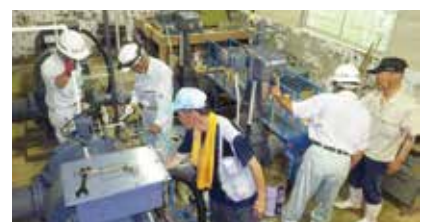
才原揚水機場
