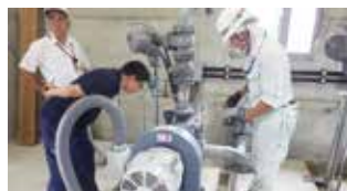
百原揚水機場
