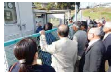
小水力発電施設の見学 (水土里ネット城原井路)
