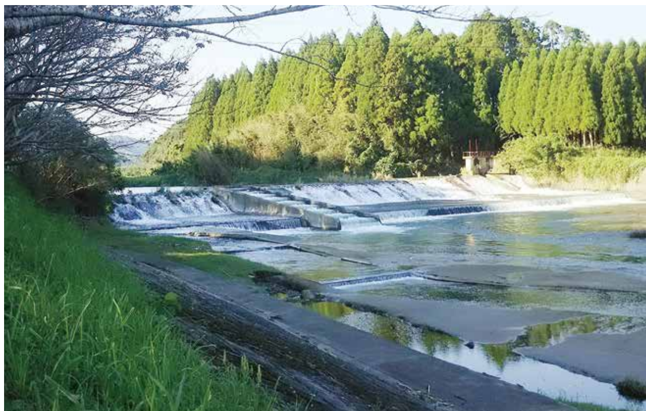
串間市 大島頭首工(水土里ネット大島堰)
