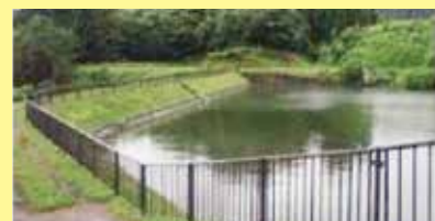
転落防止柵の整備
