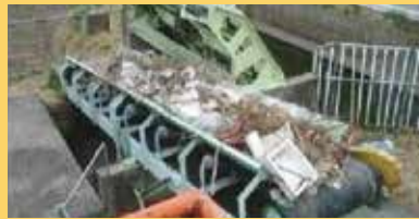
除塵機の設置
