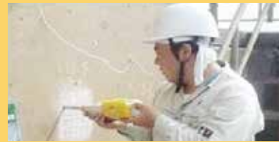
老朽化した施設の機能診断
