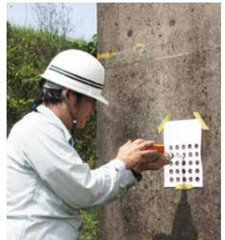
取水ゲート門柱のコンクリート圧縮強度試験状況
