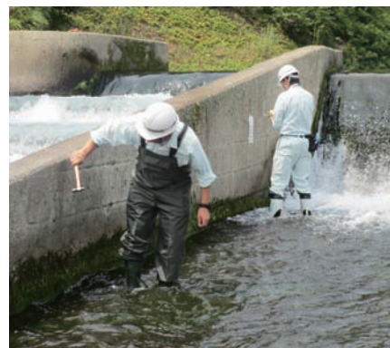
コンクリート診断状況
