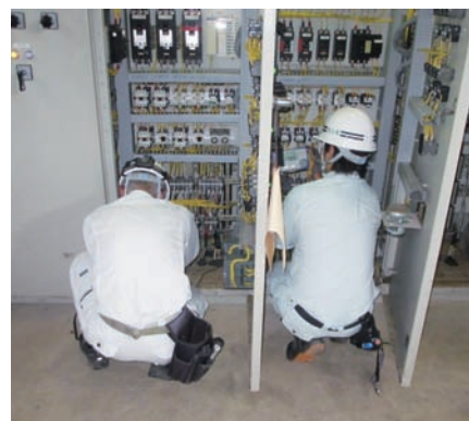
施設診断状況
